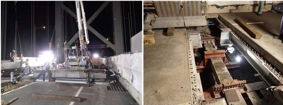
新設支承・縦桁・横桁の設置
